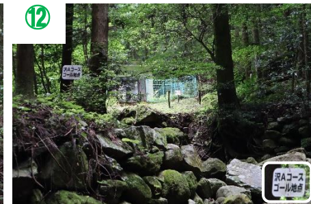
ゴールです。奥にポンプ室が見えます。
