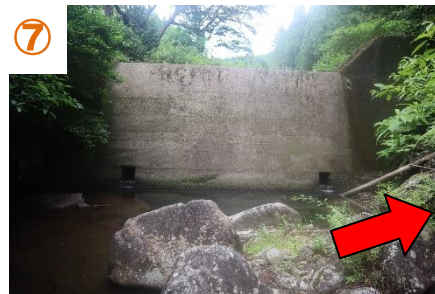
⑦ 450m付近、砂防ダムがあります。右側から迂回します。
